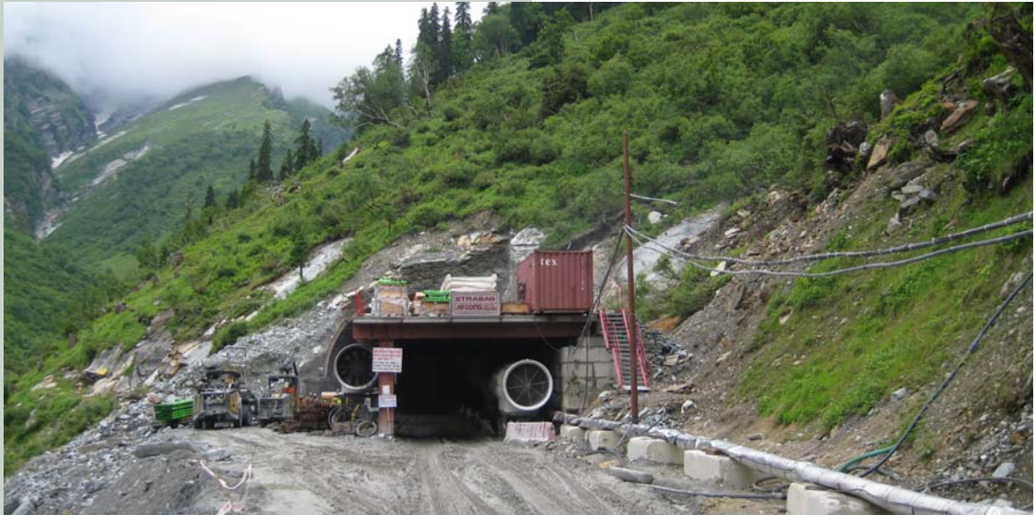
Blick auf das Südportal
