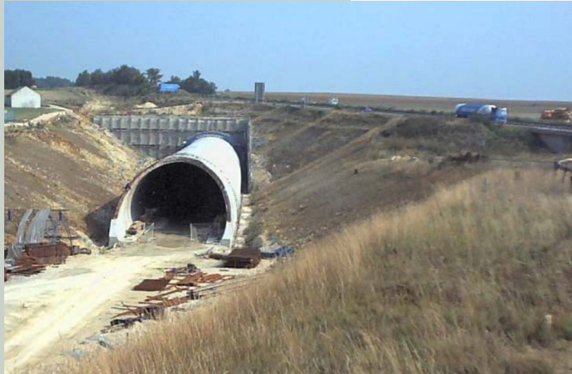
Tunnel Stammham im Bau
