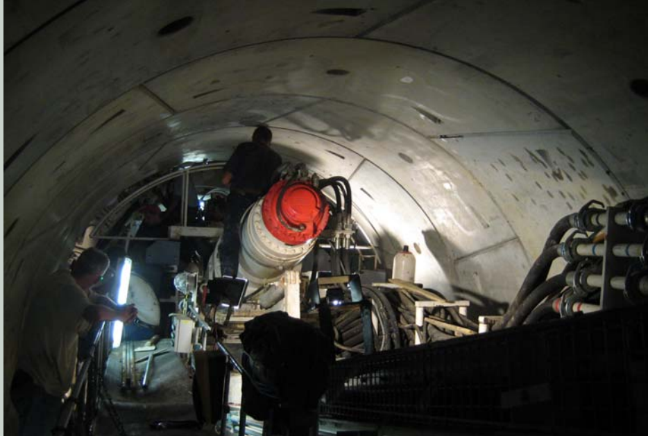
Vortriebsarbeiten in der TBM
