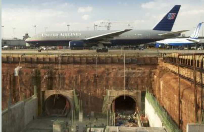
Bauarbeiten unter dem in Betrieb befindlichen Flughafen
